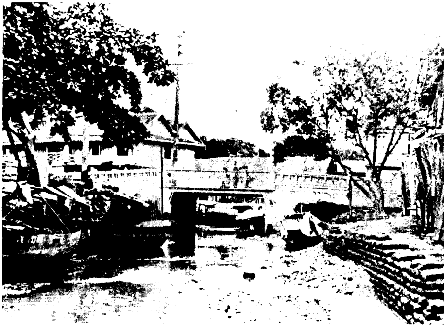
สะพานเฉลิมภาคย์ 54 ถนนเจริญกรุงข้ามคลองสี่ลม
