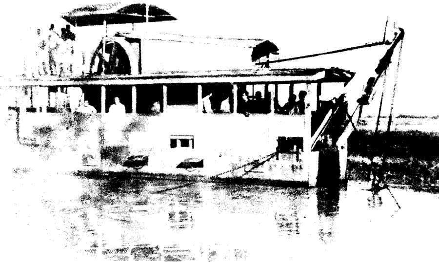
เรือชุดซึ่งเป็นเครื่องมือขุดคลองใหม่ และชุดซ่อมคลองเก่าเป็นเทคโนโลยีแบบตะวันตก เริ่มส่งเข้ามาใช้ตอนกลางสมัยรัชกาลที่ 5 ในภาพเป็นเรือชุดในคลองประเวศบุรีรมย์
