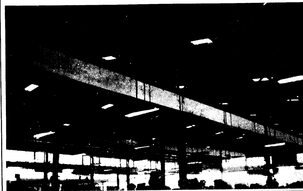
ภาพที่ 82-83-84 ลักษณะโครงสร้างตัวตลาด ที่เป็นโครงเหล็ก
