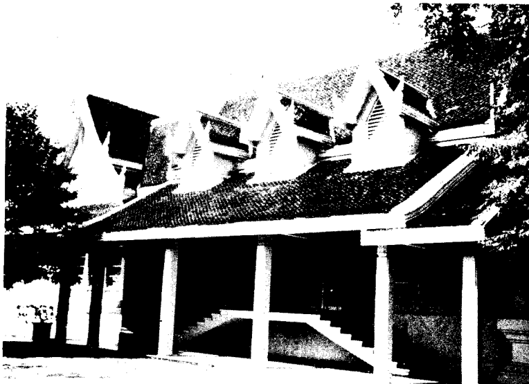
อาคารที่พักผู้ติดตาม (บริเวณสวนศิลาลัย)
